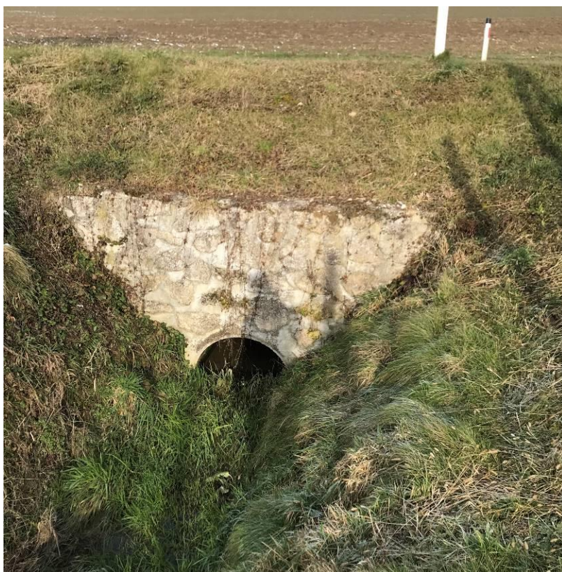
Slika 8: Izток iz prepusta pod cesto v km 3.5+70.00
